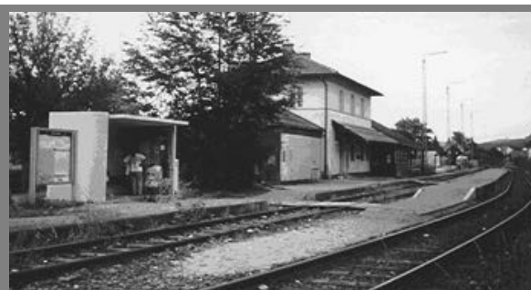
Bahnhof Schnaittach heute: Das Wartehäuschen liegt ungünstig hinter dem Bahnsteig, das Stationsgebäude ist vom Abriss bedroht.
