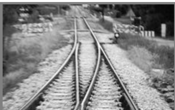
Blick aus dem Führerstand eines Zuges, der gerade einen Kreuzungsbahnhof verlässt und auf eine Rückfallweiche zufährt.
