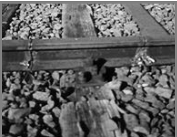
Unbrauchbar gemachtes Gleis in Simmelsdorf
